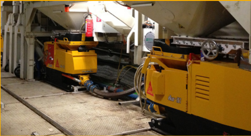
Grupo de relleno de gravilla dentro de una tuneladora (TBM)
