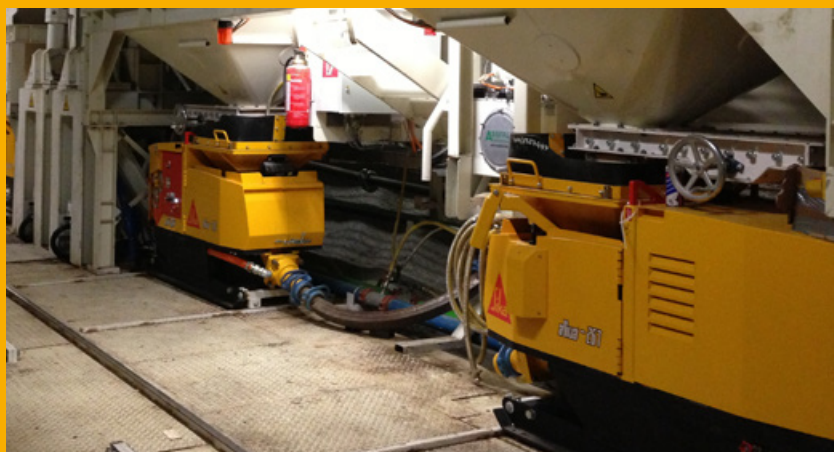
Installation de remblayage avec gravier rond sur un tunnelier
