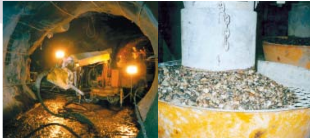
Spritzroboter auf Raupenchassis
