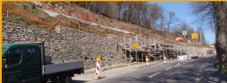
Reparación de uniones en 5000m2 aproximadamente, empresa Ehringsdorfer, Monschau / Eifel, Alemania
