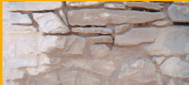
Acabados uniformes: Rellenado de uniones hasta el fondo de las mismas
